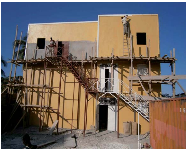
Wie gewohnt mussten auch bei diesem letzten Bauabschnitt in puncto Sicherheitsstandards beide Augen zugerückt werden.
