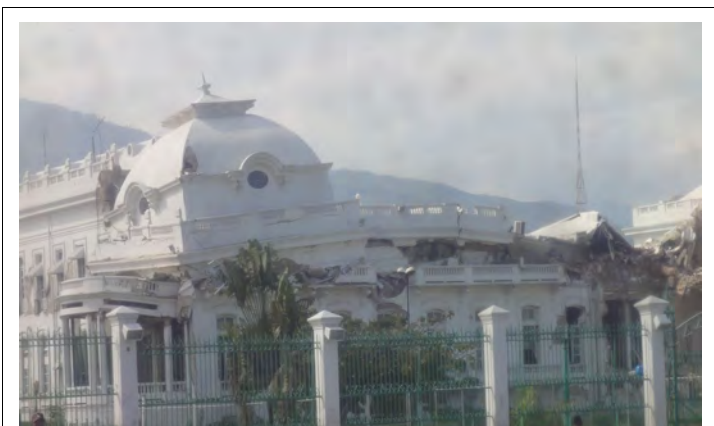
Der zerstörte Präsidentenpalast. Immer noch fast die gleiche Ruine wie nach dem Erdbeben vom 12. Januar 2010.
