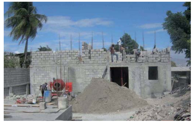
Das obere Stockwerk nimmt Gestalt an. Das Tempo ist beachtlich, hoffentlich auch die Qualität.
